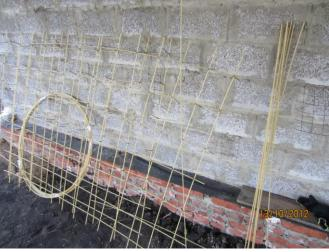
Важно – один конец арматуры в бухте прихвачен скотчем. Не удалять ни в коем случае, это внутренний конец, который фиксирует арматуру до конца ее размотки.
